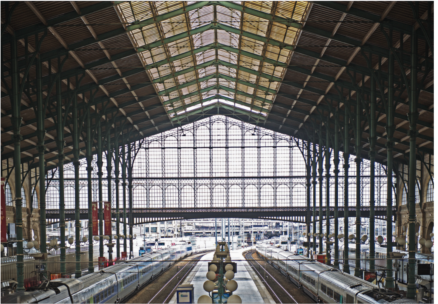
Halle gare du Nord-Paris, © CRDP Aquitaine, photographie Yann Pendaries
