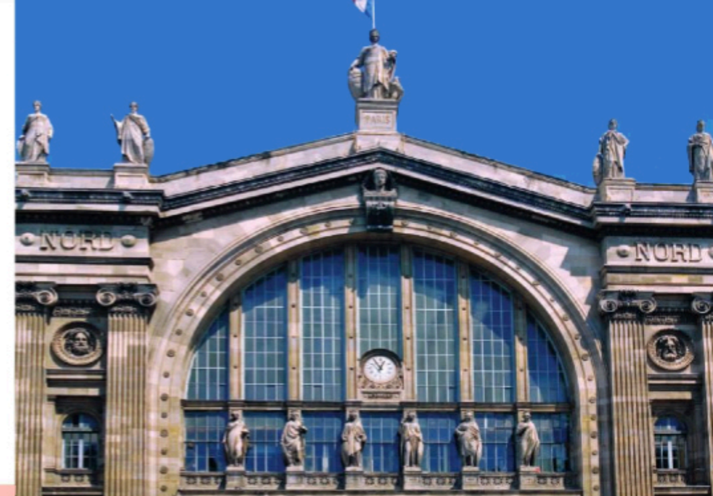
La façade de la gare
