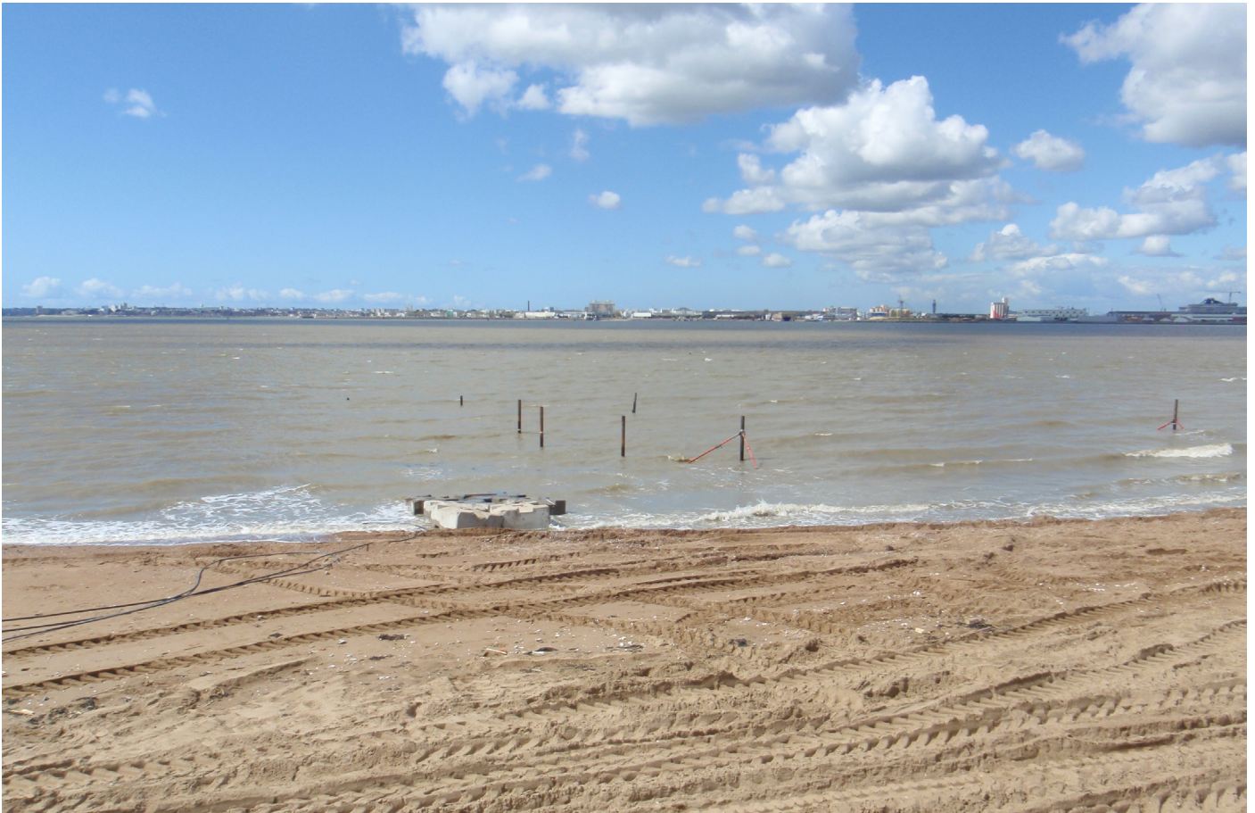
Les pieux (supports de la moelle) sont installés sur site à l'aide d'une forreuse © LVAN.
