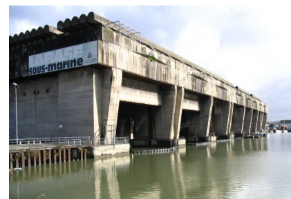
La base sous-marine, vue du bâtiment extérieur qui appartient à la ville de Bordeaux.
