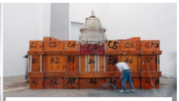
La partie extérieure est moulée, chaque moule a un numéro, puis ils sont retirés.
