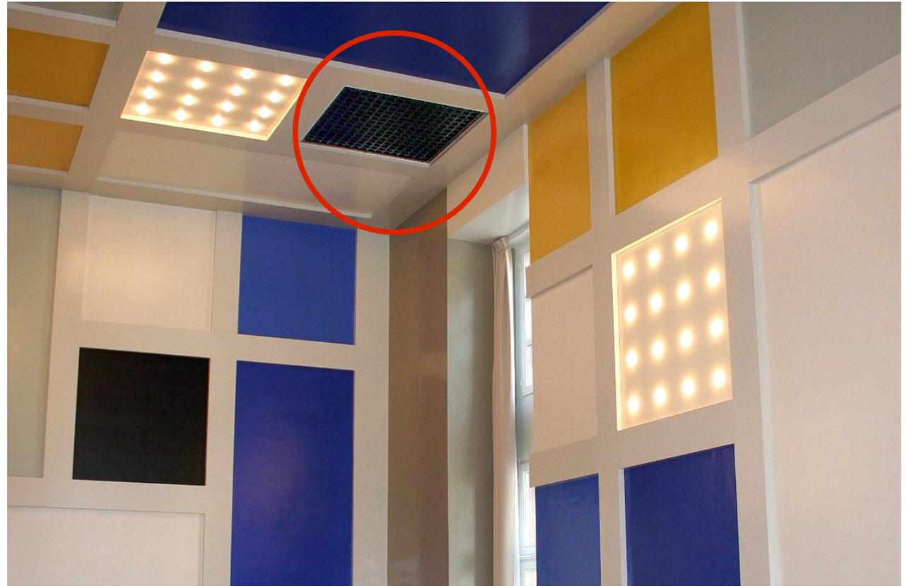
**Les grilles d'aération sont aussi mise "au carré" et intégrées**
