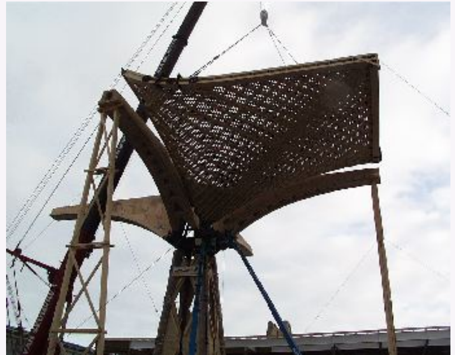
montage d'une coque
