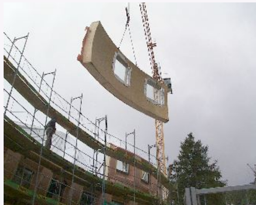
Montage sur chantier
