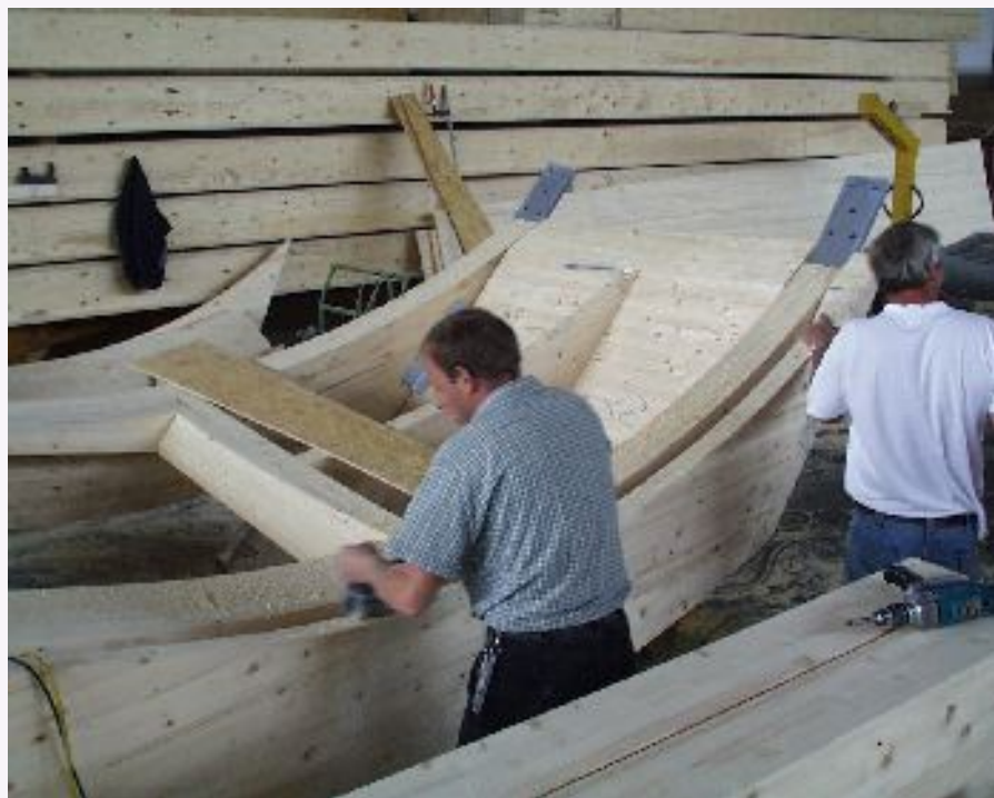
assemblage des éléments en usine
