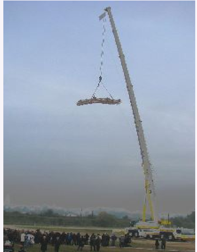
premier échantillon lors de la pose de la première pierre
