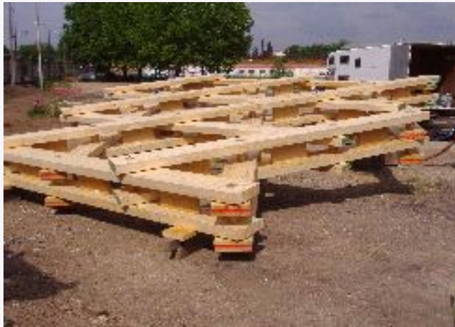
deuxième échantillon (9x9m) sur chantier
