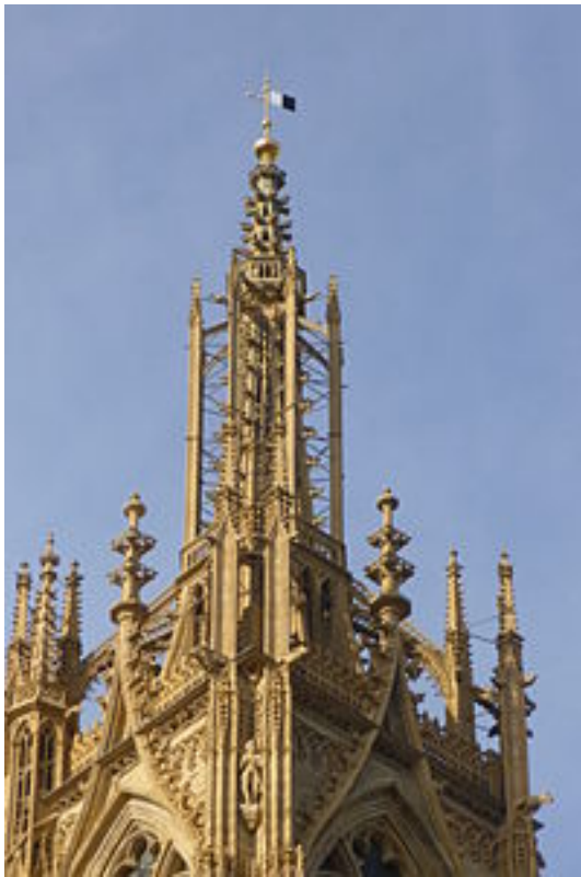
Flèche de la tour de la Mutte (hauteur : 93 m)
