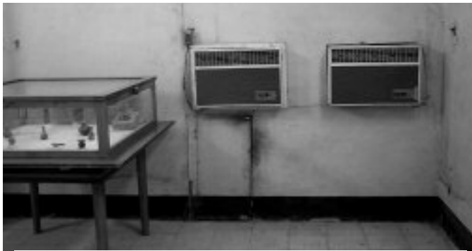
Figure 16. Petit musée typique avec des climatiseurs modernes omniprésents. Ceux-ci procurent souvent autant de dommages aux artefacts que de confort pour les visiteurs et le personnel. Ils entraînent souvent une humidité relative élevée et des sources de condensation.
