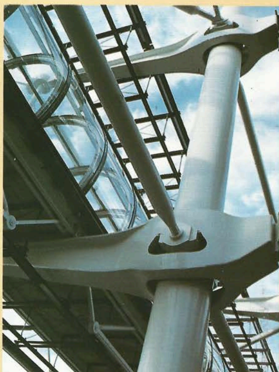
Élément de support des planchers et galerie de circulation. © Doisneau-Rapho.
