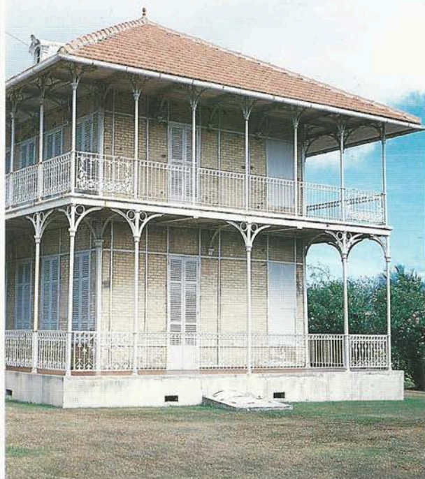
Maison de style « colonial » à Zévalos, Guadeloupe. Les éléments d'architecture en fer ont été construits dans les ateliers de Gustave Eiffel à Paris. © Pix-Dusart.
